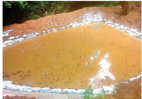
वन्यजन्तुको लागि पानी पोखरी निर्माण (ऐनडाँडा)
