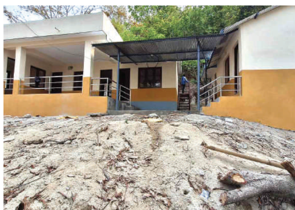
पोष्ट भवन निर्माण (नयाँपाटी)
