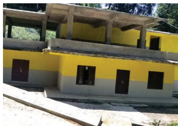
अधुरो भवन निर्माण (पानीमुहान)
